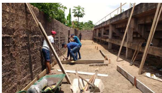
Figura 2: Construção da horta, Escola Frei Fabiano Merz - Santarém PA. Foto: Arquivo Pessoal
