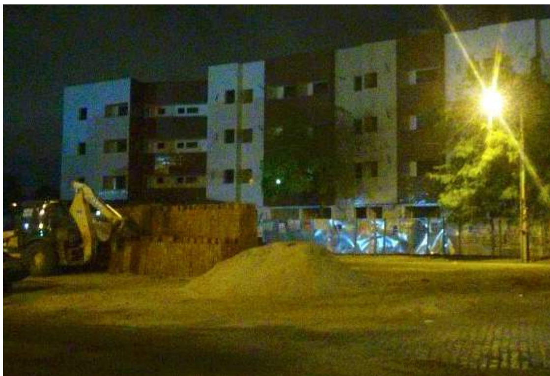
Foto 8. Visão, desde a Rua 02 de Fevereiro, da construção do Residencial Príncipe do Rangel
