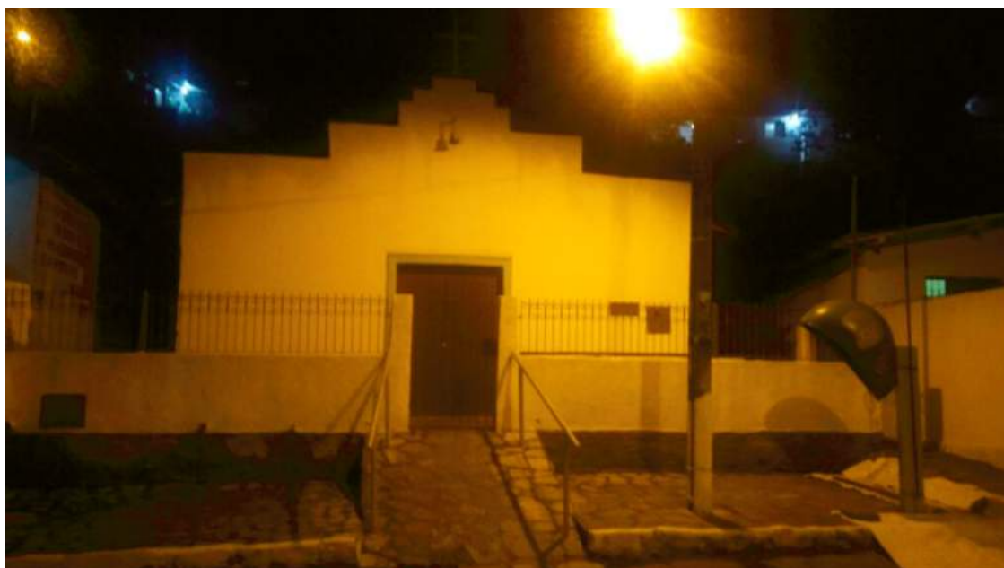
Foto 6. Visão frontal da Igreja Nossa das Graças, na Rua Oswaldo Lemos, fronteira norte do Varjão Rangel com o bairro de Jaguaribe. Os bairros são separados pelo Rio Jaguaribe.
