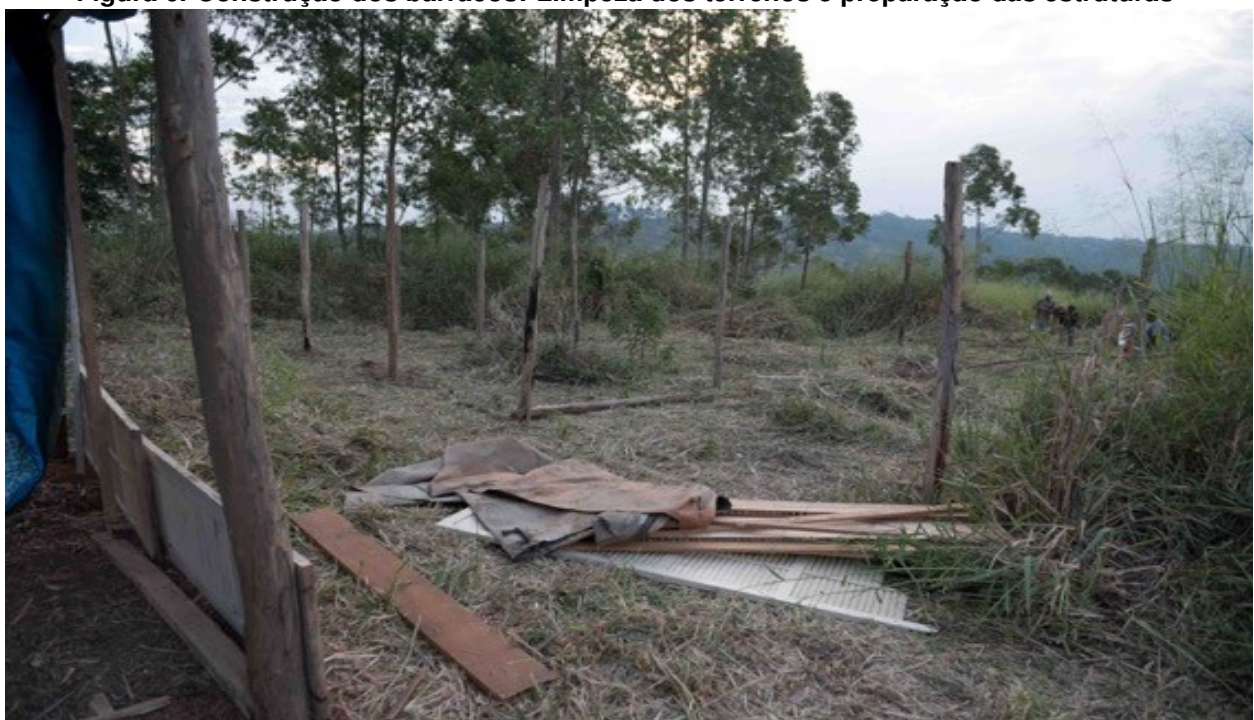
Figura 6. Construção dos barracos: Limpeza dos terrenos e preparação das estruturas
