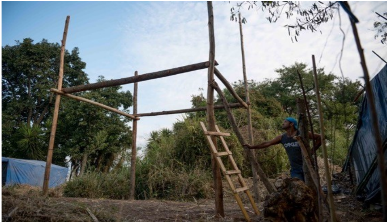
Figura 5. Construção dos barracos: acampados constroem barracos de todos os tipos, inclusive com dois andares, assim podem dormir no segundo andar e portanto protegidos de animais peçonhentos
