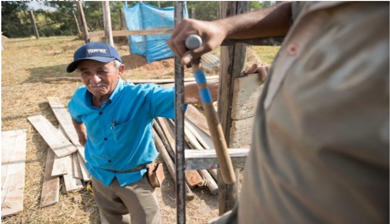
Figura 3. Construção dos barracos: um dos mais fascinantes aspectos é a troca de conhecimento entre diferentes gerações. A oralidade se torna o principal meio de transmissão de saber
