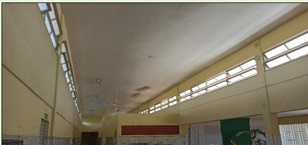
Figura 13: Aberturas zenitais para iluminação e ventilação (lanternins)
