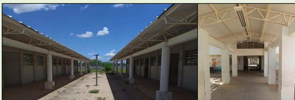
Figura 2: Setores que sofrem com alagamentos em dias de chuva
