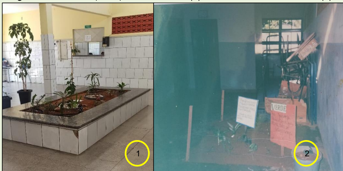
Figura 14: Canteiro principal atualmente (1); canteiro menor removido (2)
