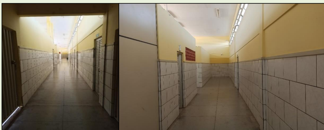
Figura 12: Corredor principal da edificação
