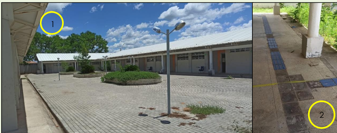
Figura 3: Pátios sem passarelas cobertas (1); sinalização piso tátil (2)
